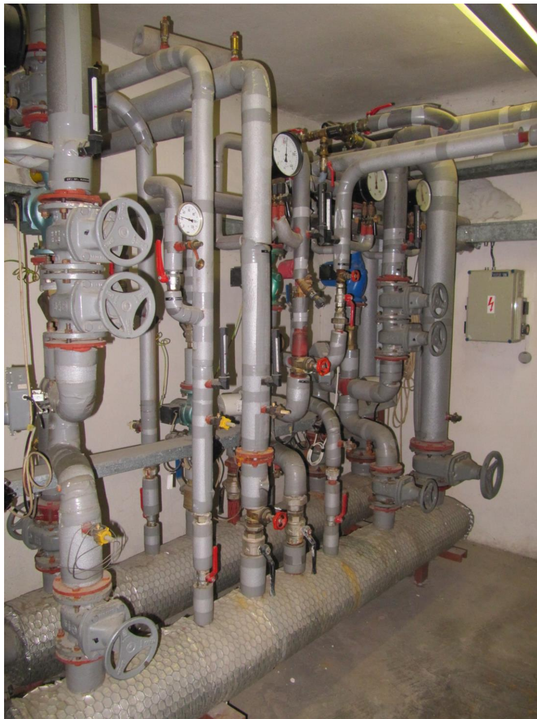
Foto č. 2 – pohled na stávající rozdělovač UT
