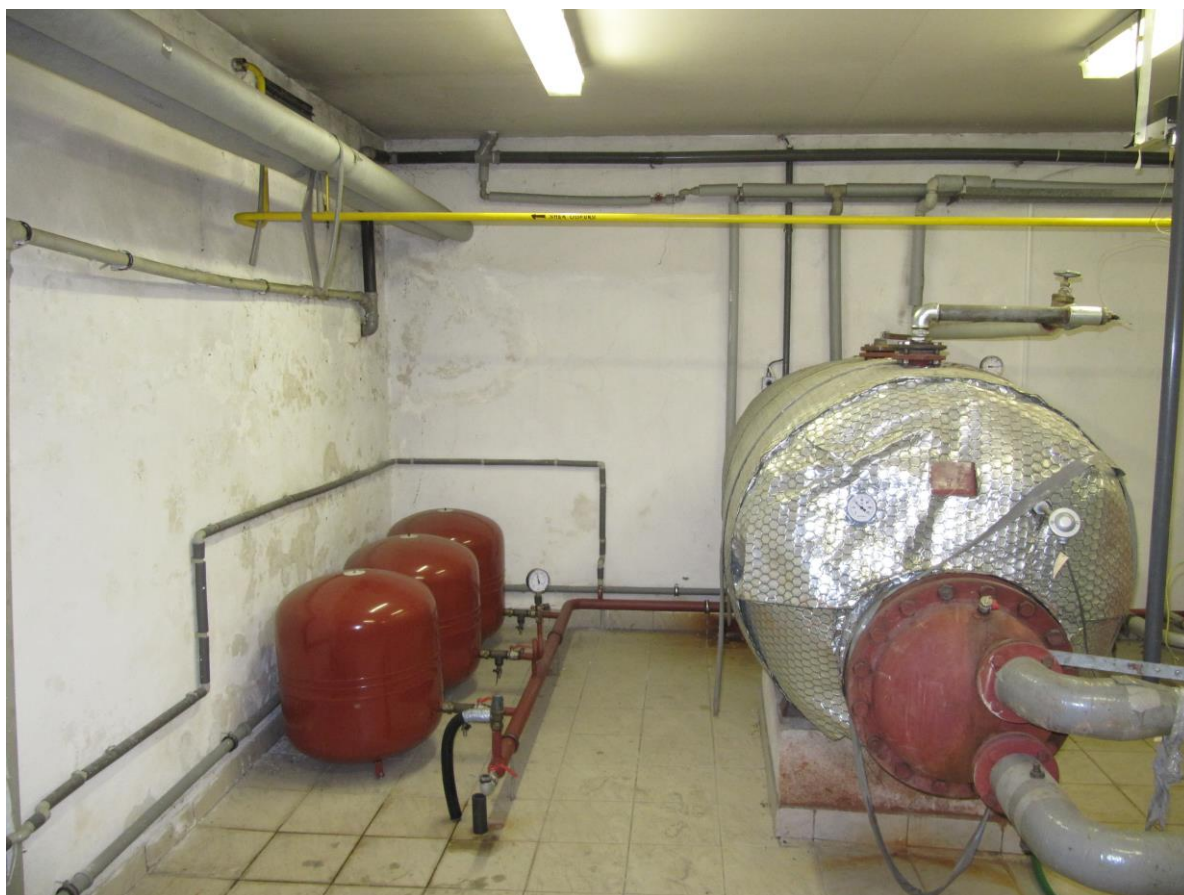
Foto č. 2 – pohled na stávající ohřev TV a expanzní nádoby
